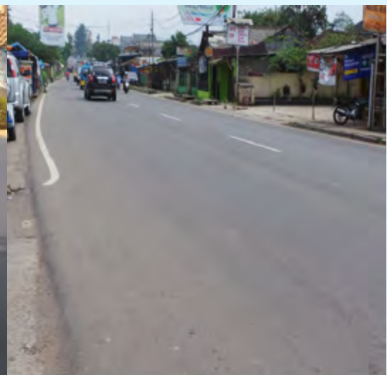
Gambar 3. Kondisi Ruas jalan dengan Teknologi Campuran Hangat Eco-BPJ Umur 1 Tahun
