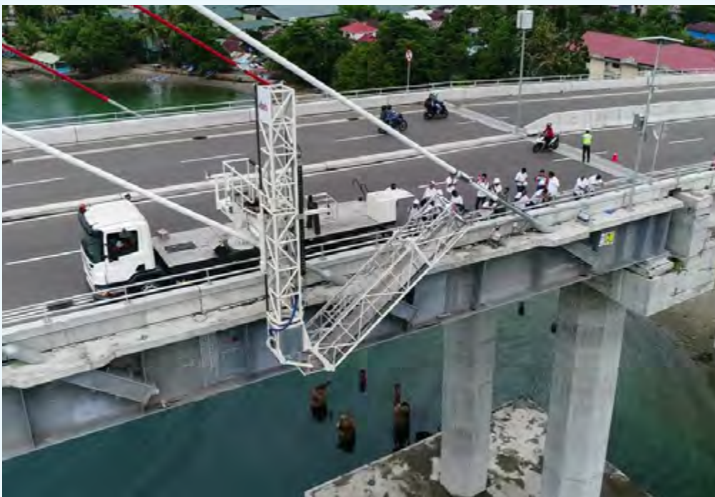
Proses pembangunan Jembatan Bareleng
