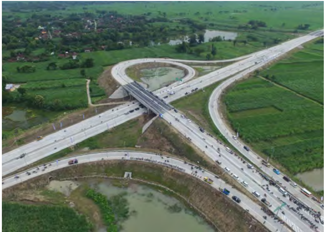
Pembangunan Infrastruktur jalan tol
