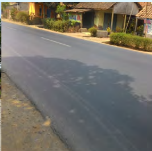
Gambar 2. Kondisi Ruas jalan dengan Teknologi Campuran Hangat Zeolit Umur 4 Tahun
