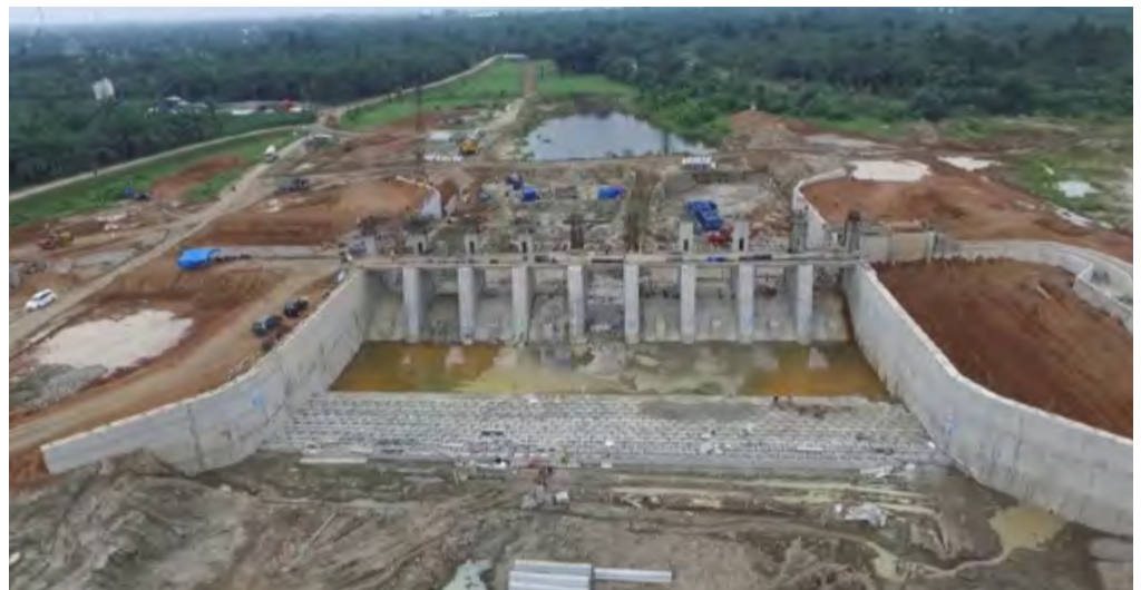
Pembangunan bendungan Sei Pandan
