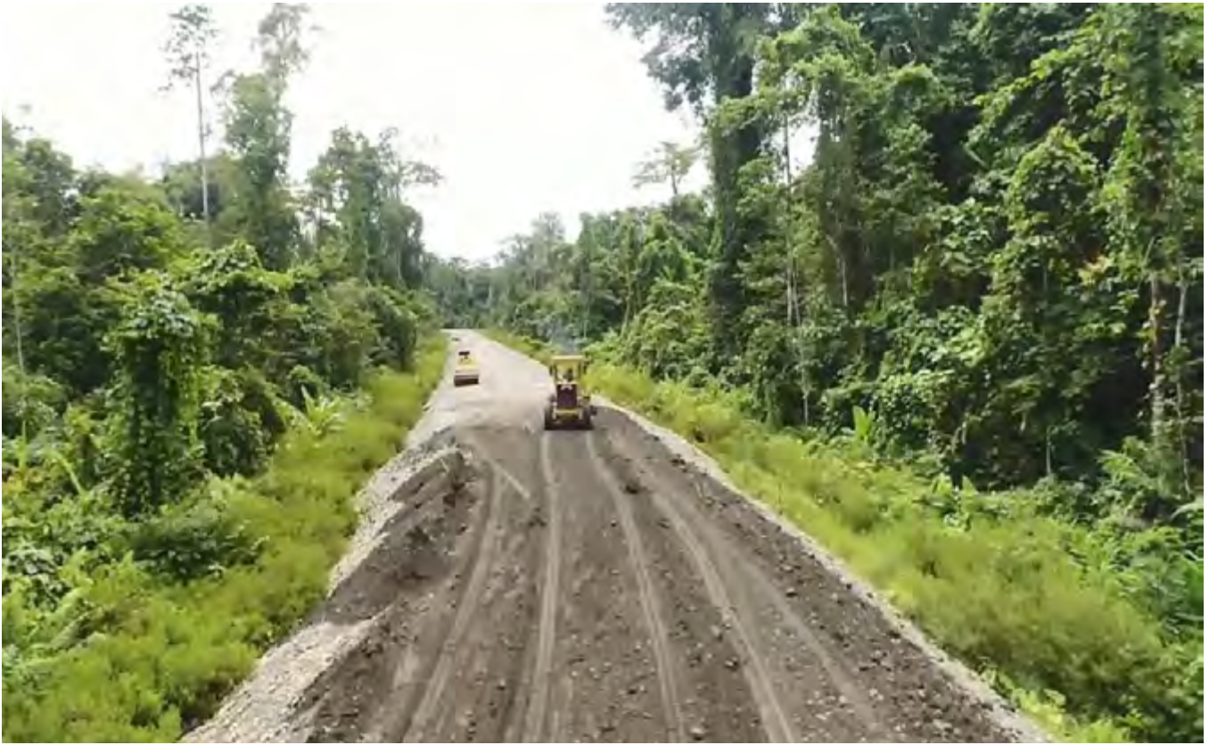
Pembangunan jalan Kenyam - Batas Batu
