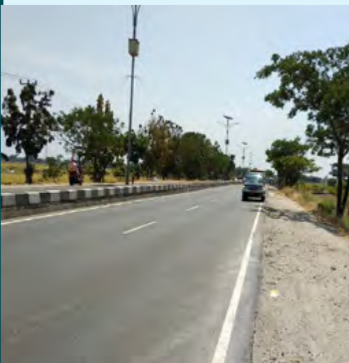
Gambar 1. Kondisi Ruas jalan dengan Teknologi Campuran Hangat Econuska Umur 4 Tahun
